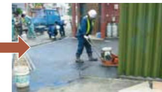
アスファルト仕上げ
