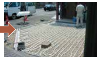
放熱管・架橋ポリパイプ敷設 ※電気式はヒーティングケーブル敷設
