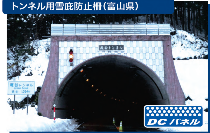
トンネル用雪底防止柵(岐阜県)
